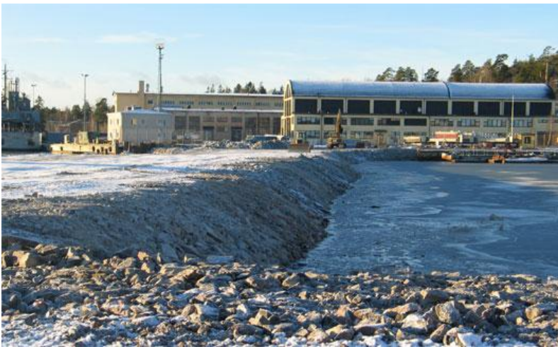
Kuva 6 . Pansion satamaan rakennettu pilantuneiden massojen stabilointiallas. (Turun Satama 2005 [viitattu 22.4.2011] )
